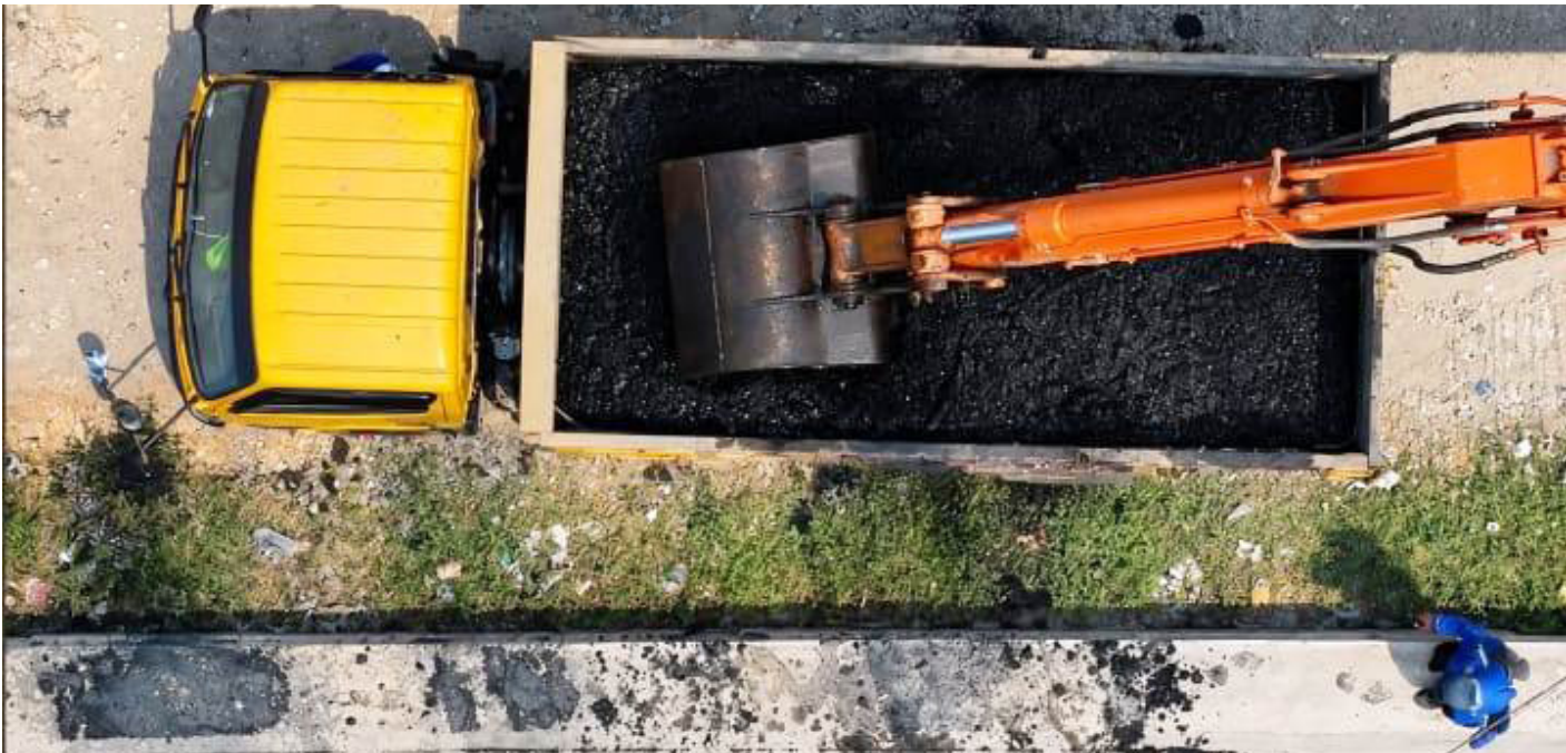
Pemerintah Kota Tangerang melalui Dinas Pekerjaan Umum dan Penataan Ruang (PUPR) mengencarkan normalisasi sungai dan saluran air di musim kemarau.
