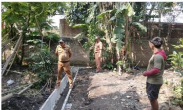
Pemkot Tangerang terus gencar dalam meniadakan kota layak di huni. Seperti perbaikan drainase yang dilakukan di RW 02, Kelurahan Pajang, Kecamatan Benda. Perbaikan sepanjang 150 meter dan lebar 40 meter menggunakan u-ditch ukuran 40 cm dilaksanakan oleh Dinas PUPR Kota Tangerang saat ini masih berlangsung.
